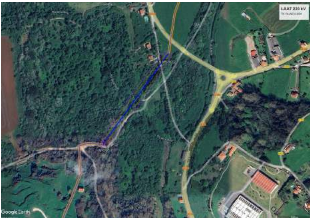
Línea aérea de alta tensión 220 kV
