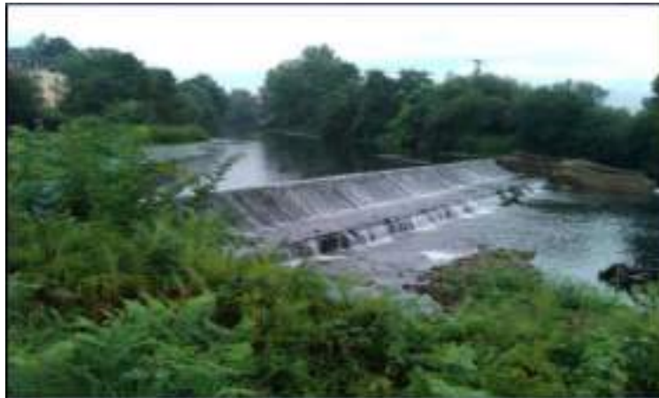
Figura 39. Estación de aforo 1217 La Penilla. Fuente: CHC.
