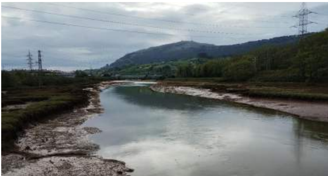
Fotografía 2. Coincidencia del tramo 2 de la línea aérea de evacuación de las alternativas 2 y 3 con la ría de Solía.
