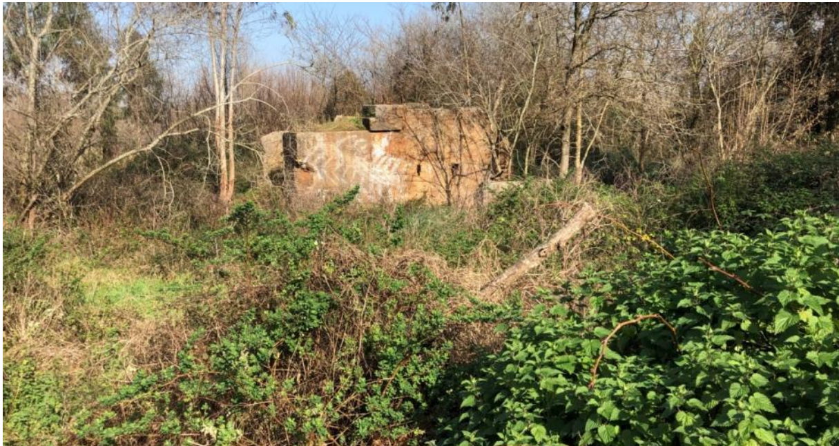
Figura 24. Estado actual de los lavaderos de mineral de Orconera. (Foto MSarqueo).
