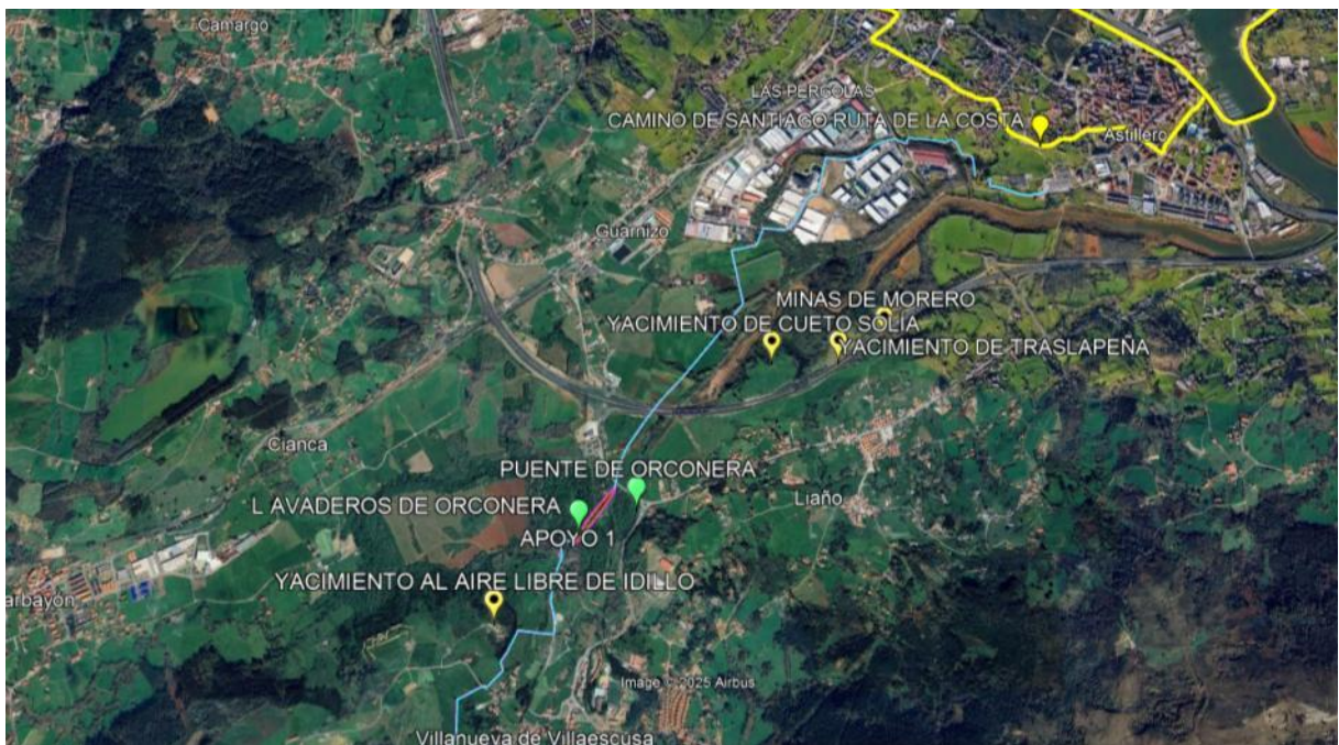
Figura 26. Detalle de la posición de bienes culturales afectados en la zona del trazado del tendido eléctrico. (Elaboración propia a partir de Google Earth).
