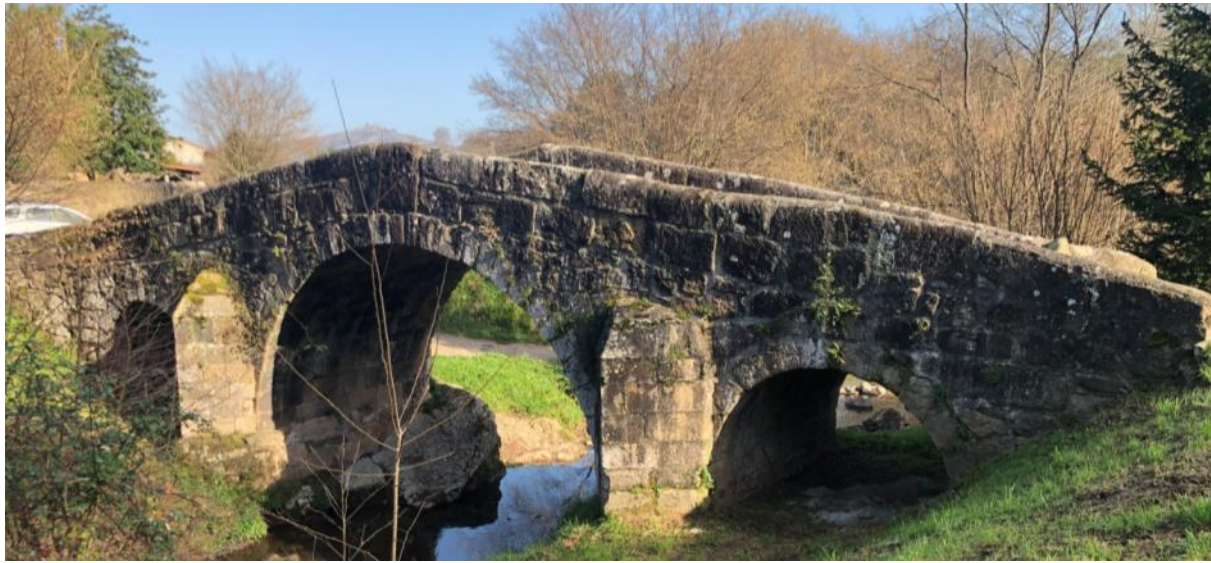
Figura 32. Puente de Búmbara, en Llanos. (Foto MSarqueo).
